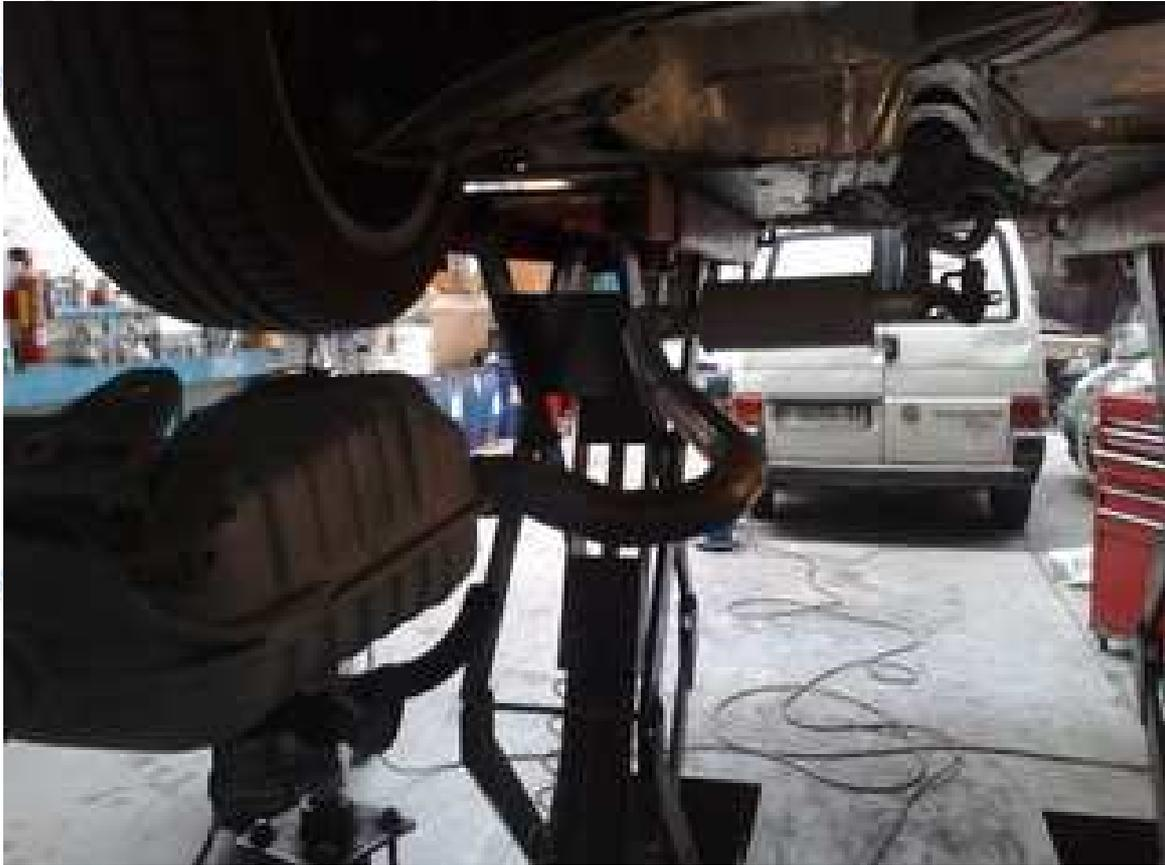
Después de ese silencioso vaciar los traseros y antes de estos hacer la "Y" de manera artesanal con el soldador y la radial limando al máximo las soldaduras para que se note lo menos posible
